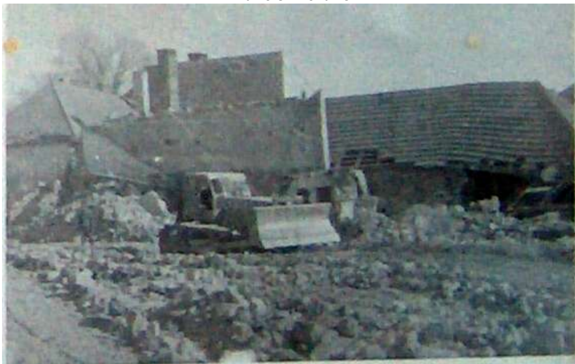
Demolice domů na Bližné počátkem sedmdesátých let 20.století
