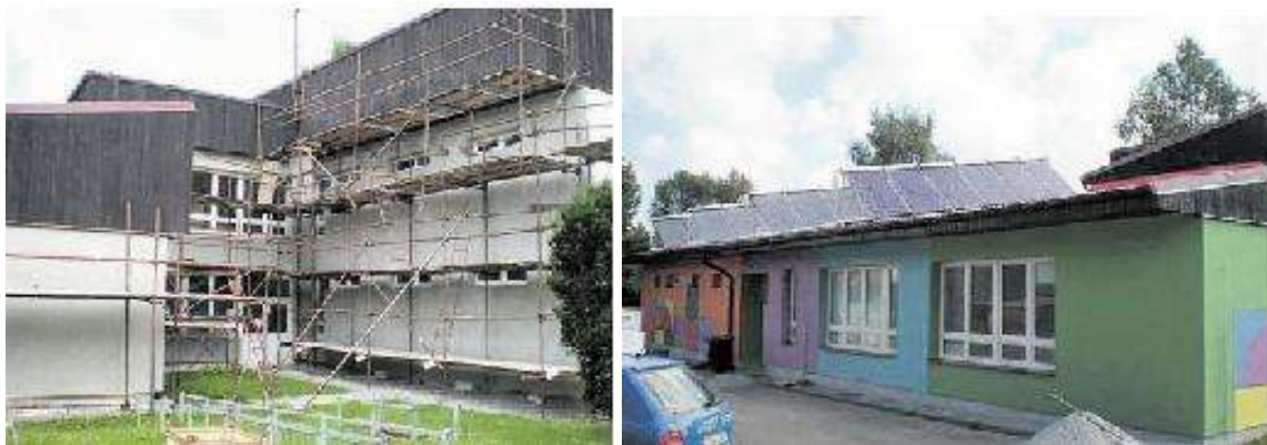
Rekonstrukce: Vlevo je zachycen začátek prací, vpravo jsou viditelné solární panely
