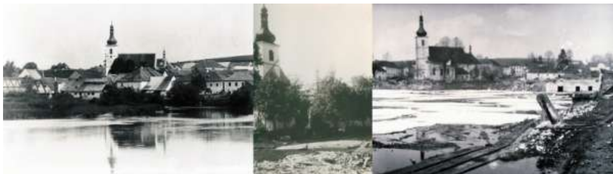
Dolní Vltavice 1911 + začíná demolice budov, kostel stále ještě odolává
