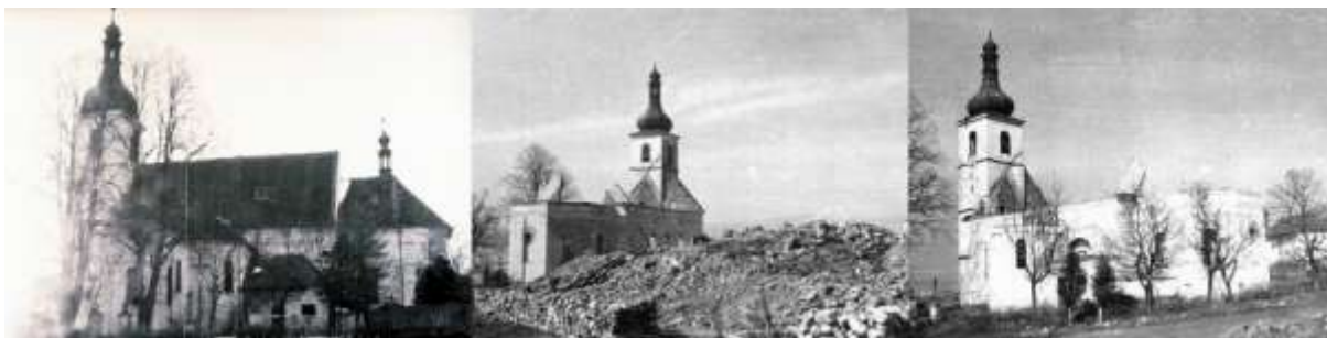
Demolice pokračuje, kostel zůstává nakonec- rok 1958
