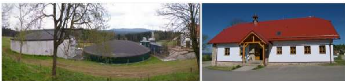
Nová bioplynová stanice + administrativní budova na Milné
