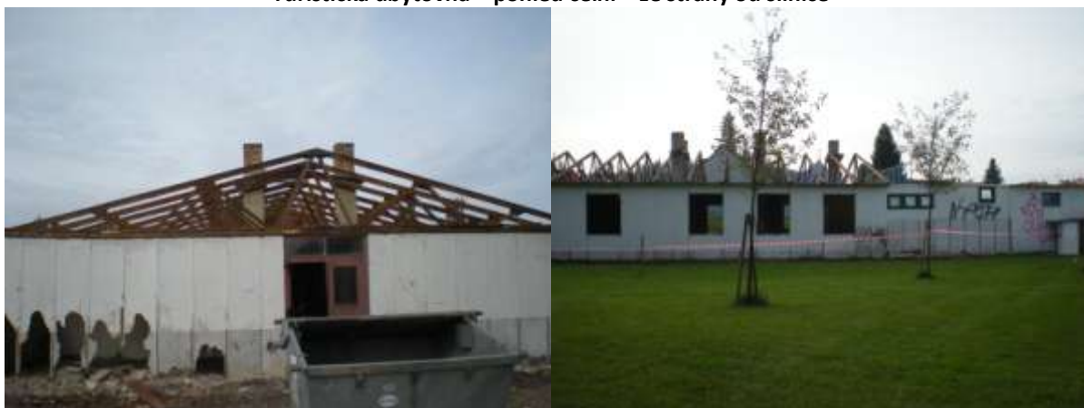
Začala demolice turistické ubytovny ( říjen 2013)
