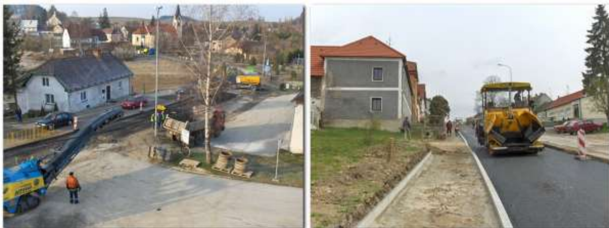
Průběh prací v obci – 27.3.2007 + 4.4.2007
