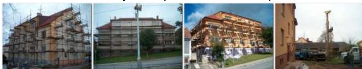
Generální oprava bytoven – č.17 bytovka 3.11.2003 + č.19 bytovka 16.7.2004 + č.19 bytovka 24.9.2004 + č.19 vrt na tepelné čerpadlo 15.10.2004
