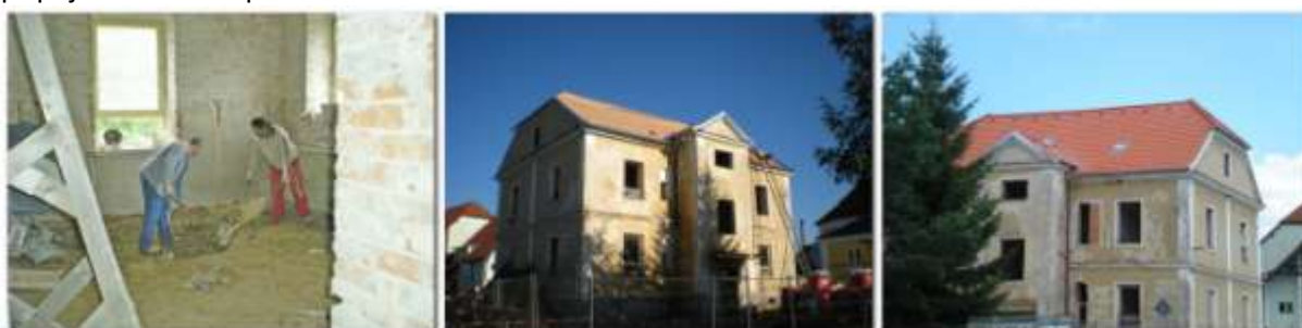
Foto uvnitř 13.6.2012 + stará střecha 3.8.2012 + nová střecha 14.8.2012 – F.Z.
