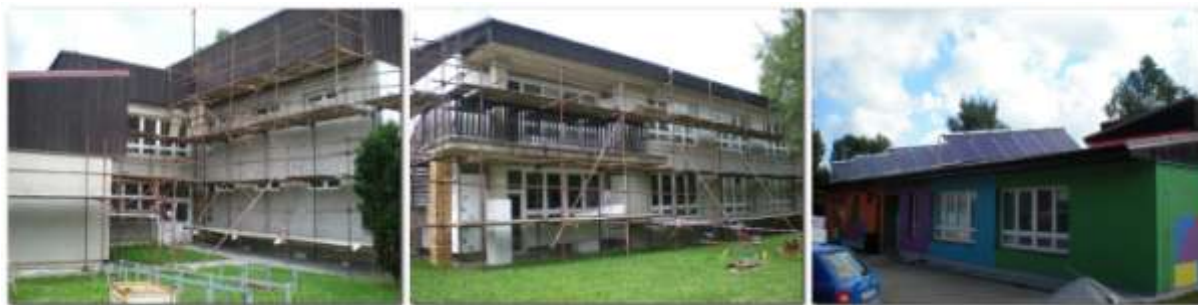
Začíná rekonstrukce 25.7.2010 – obr. 1 a 2 + ukončení – solární panely 6.9.2010 – F.Z.
