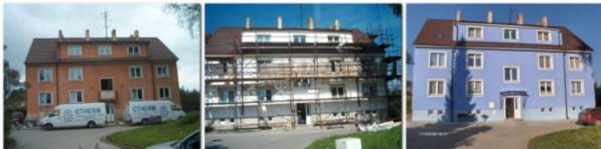
Snímky bytového domu č.25 = 17.5.2005 + 12.8.2005 + 11.10.2005
