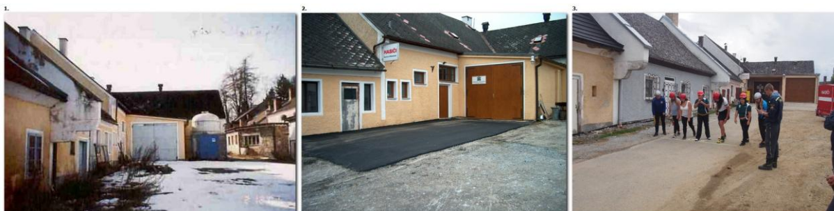
Obec odkoupila část nemovitostí a byla zřízena hasičská zbrojnice
