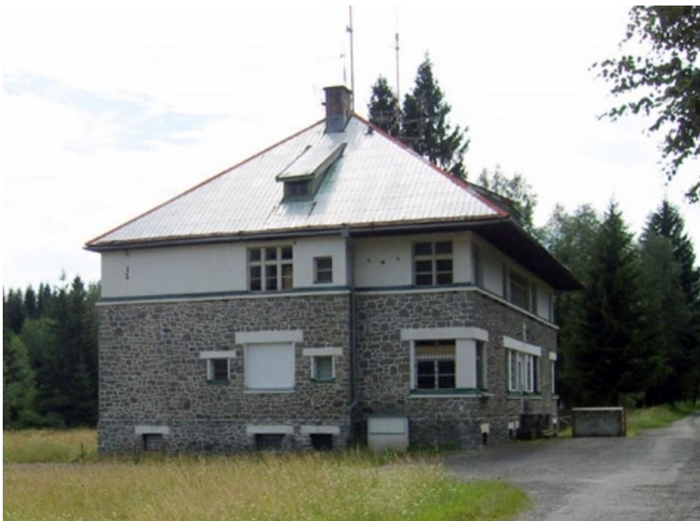
Rota se nacházela v budově bývalé prvorepublikové celnice. Objekt postavila firma A.Knížka, stavitele z Vodňan. Kolaudace budovy proběhla 25.9.1934.
