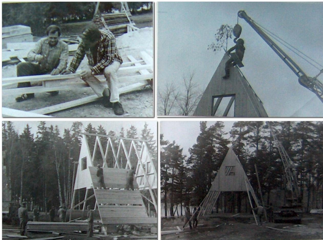
Z výstavby tábořiště Olšina / 1971 – archiv kroniky obce/
