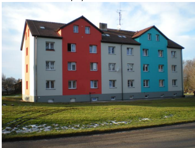
Bytový obecní dům čp. 36, tzv. Svobodárna
