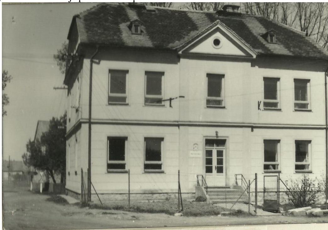
Budova Mateřské školy a školní jídelny MŠ do r.1983 - původně fara
